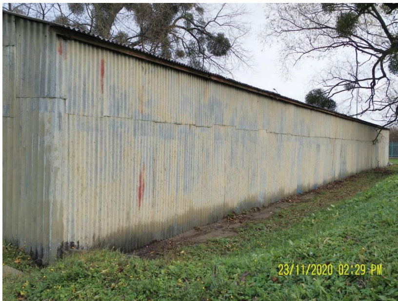
Widok południowo -zachodni.
